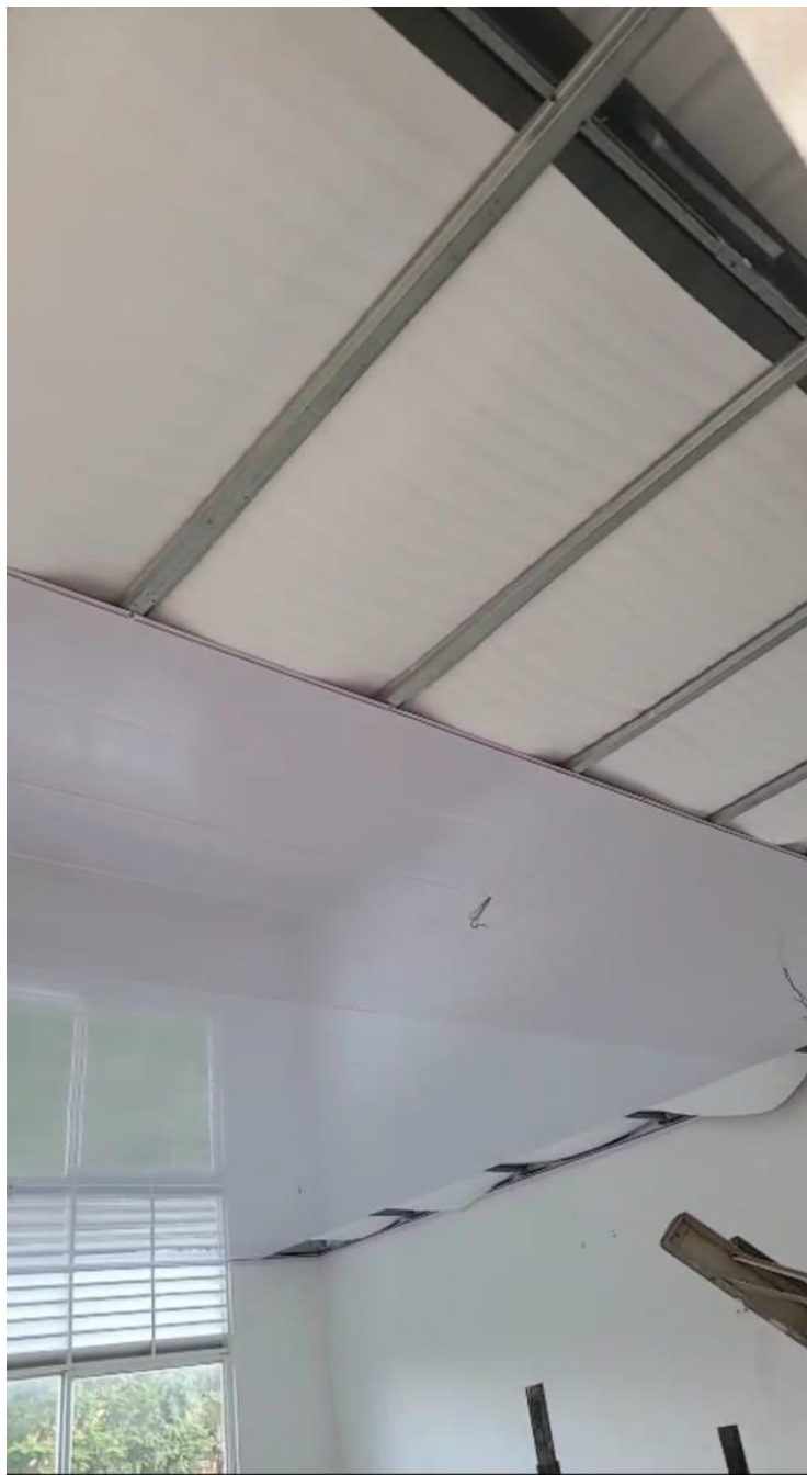
Ilustración 1 Reparación del techo de los salones del bloque F en convenio con TQ
